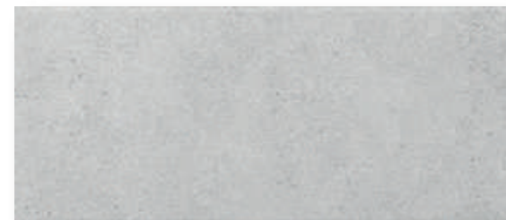
Pavimento baño pasillo
