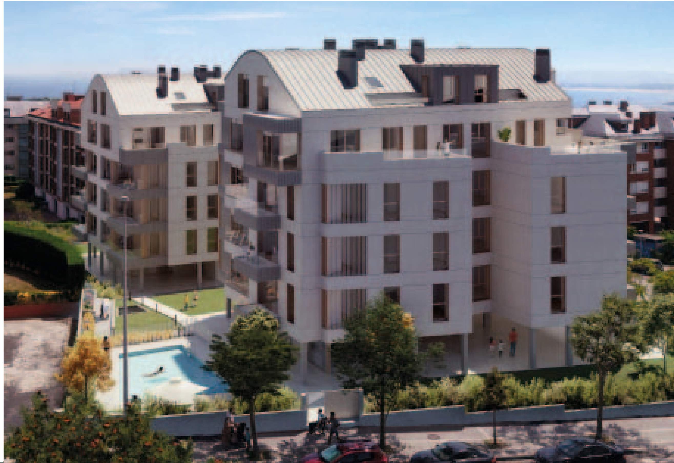
Vista fachada lateral y piscina
